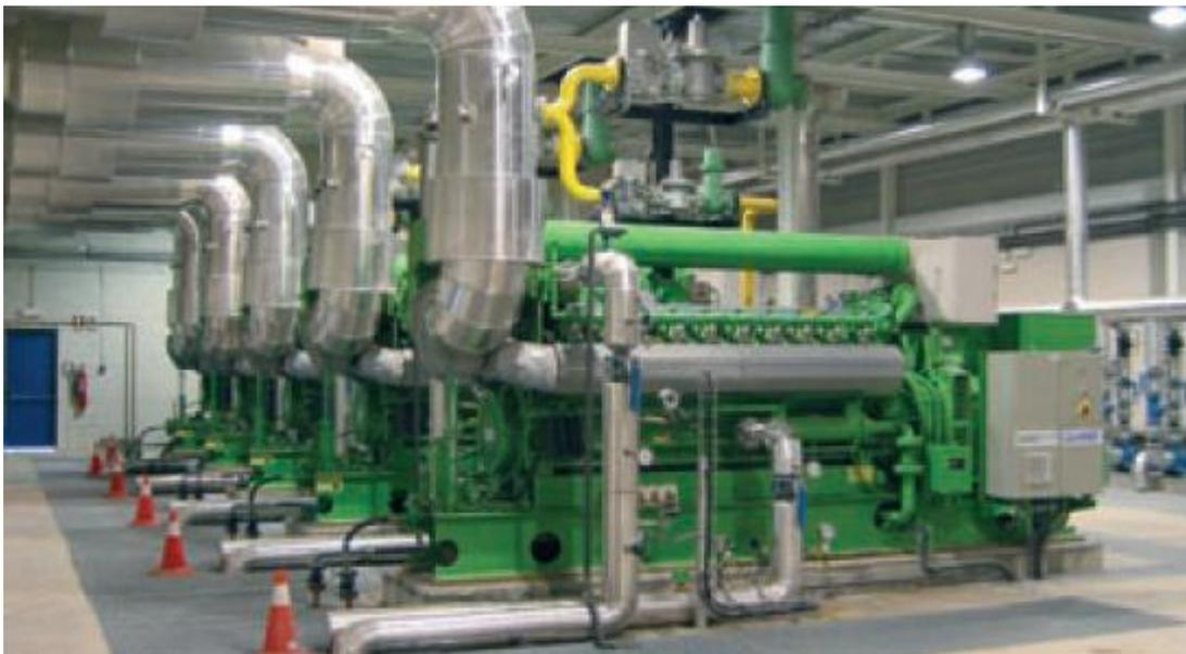
Die Auslegung der zentralen BHKW Anlage muss so gewählt werden, dass ein möglichst wirtschaftlicher Betrieb der Anlage möglich ist. Bei einem wärmeseitig geführten Betrieb sind jährliche Betriebsstunden von mehr als 5.000 Stunden erforderlich. Wir haben mit einer Modellanlage gerechnet, die mit einer Wärmeleistung von 1.332 kW bei 33% der Spitzenlast von 4.000 kW liegt. Bei dieser Auslegung ist ein ganzjähriger Grundlastbetrieb mit ca. 7.000 h/a zu erwarten.
