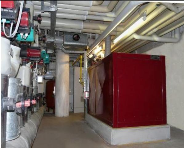
Comuna Metall BHKW Blockheizkraftwerk Typ 2726/50 kW elt/110 kW th
