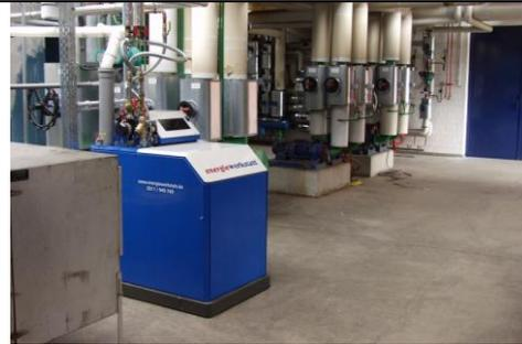
Mikro-BHKW ASV 14/32 (energiewerkstatt) mit 14 kW elektrischer und 32 kW thermischer Leistung
