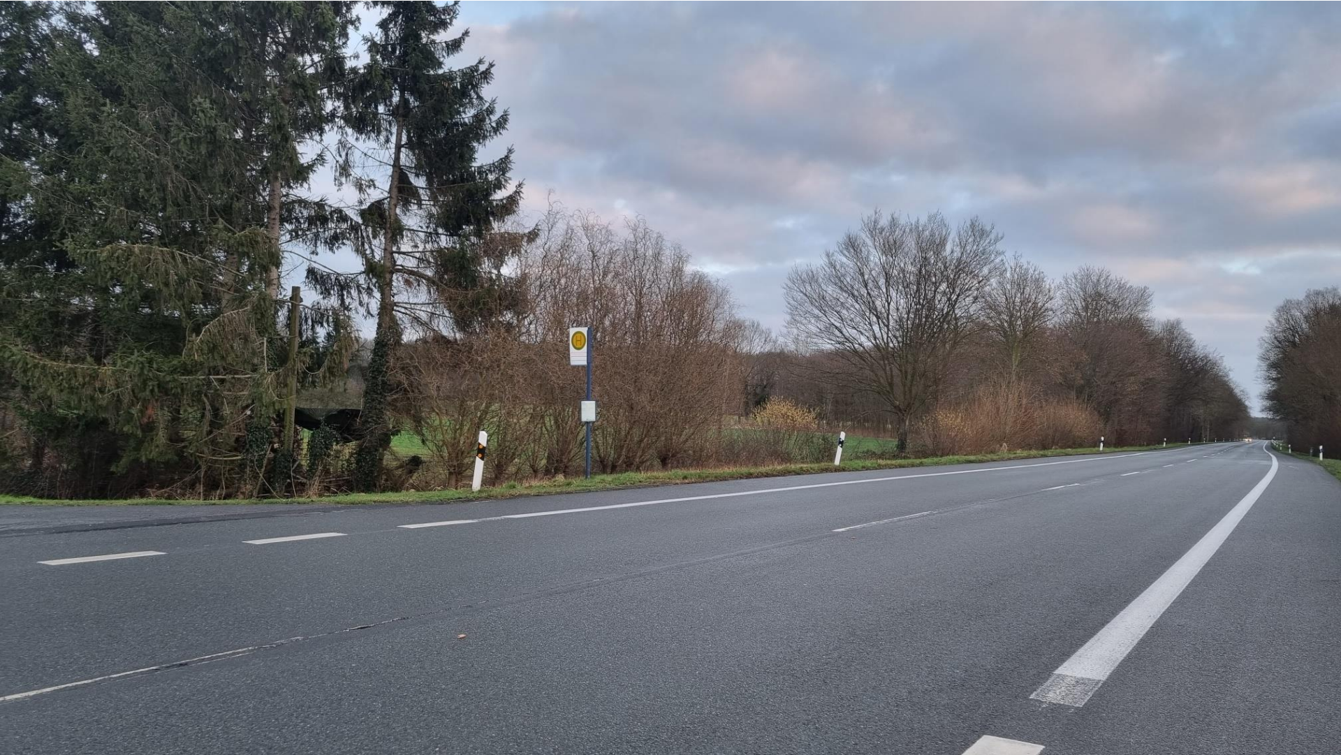
Bushaltestelle Station 0+838 – Foto Bestand
