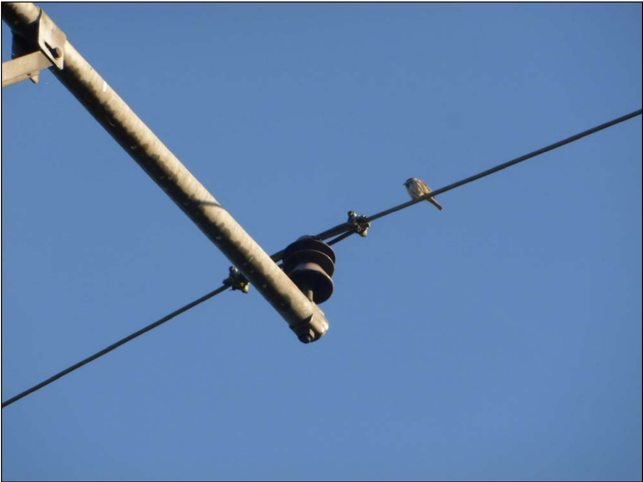
Abb. 2: Feldsperling am Brutplatz im Querrohr der Mittelspannungsleitung
